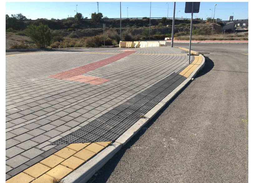
IMAGEN DE PAVIMENTO EJECUTADO.
